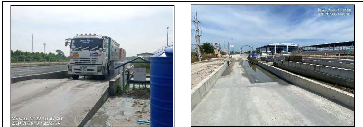
ภาพที่ 2-10 : ล้างล้อก่อนออกจากพื้นที่โครงการ
